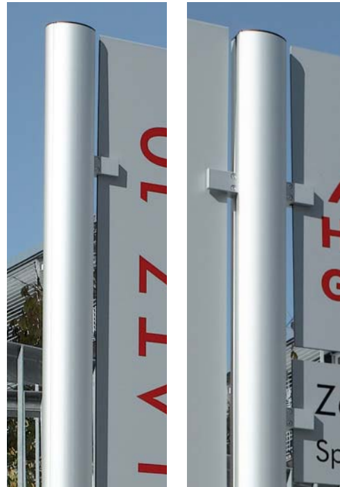
1 Seitenprofil aus Aluminium mit Montagenuuten und Kunststoffabschluss, Aluminiumprofil
