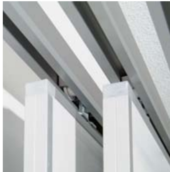
Laufschiene objektbezogen in die Decke eingelassen
