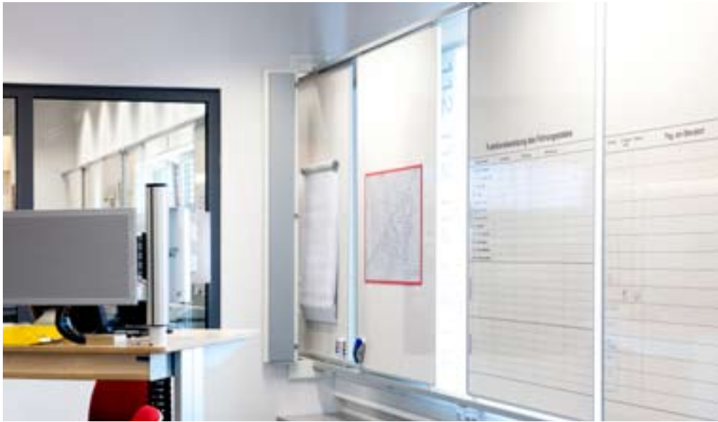
Schiebeanlage läuft durch zwei Räume. Die Wandklappe mit Schallisierung wird bei Bedarf geöffnet, so das in beiden Räumen alle Magnettafeln jederzeit zur Verfügung stehen.
